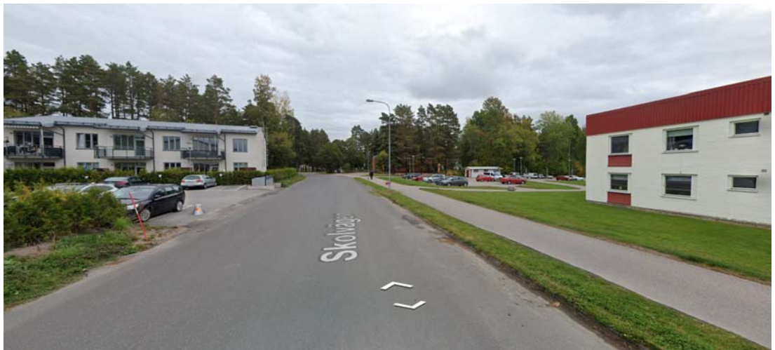
Skolvägen i Valbo. Den befintliga panncentralen (tegelbyggnad) skönjas bakom tallarna i mitten av bilden. Bild tagen från Google Maps 2020-02-27.
