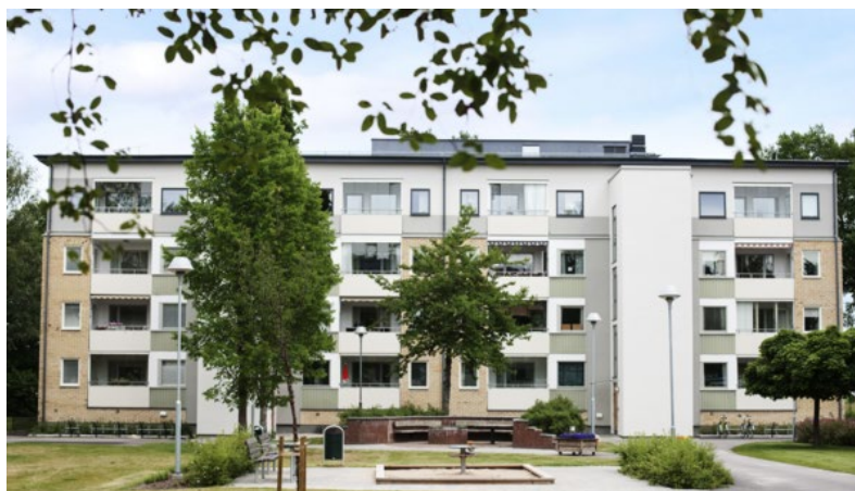
Lägenhetsbus inom projektet Skarpan i Linköping där 150 lägenheter tillförts genom påbyggnad av ett fjärde våningsplan.
