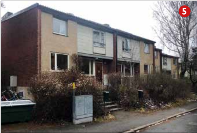
Radhus vid Riksrådsvägen och kolonistuga i funkisstil.
