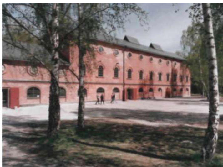
Nobels svavelsyrafabrik från 1891 har rustats upp och rymmer numera Skulpturens Hus, ett av flera projekt som ingår i Kulturpark Liljeholmen. Byggnaden, som är K-märkt, rymmer även ett museum över Alfred Nobel och industriverksamheten på platsen. Arkitekter för ombyggnaden var Stefan Hagdahl och Ola Tafvelin.
