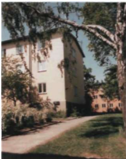
Gavlarna tilläggsisolerades vid ombyggnaden och fönstren flyttades ut i det nya fasadlivet.
