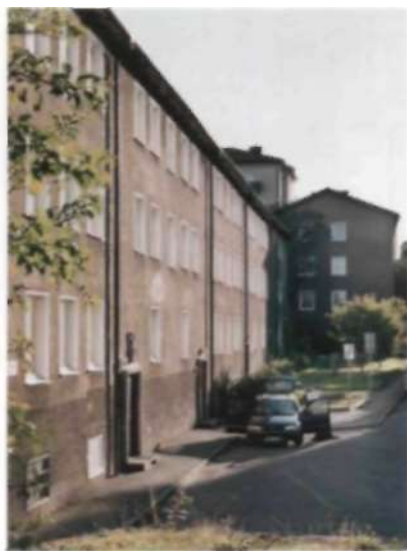
Husen längs Ekensbergsvägen har grovt putsade fasader med tunna vita omfattningar kring fönstren. Många av portarna har fått en konstnärlig utsmyckning genom tidstypiska reliefer.
