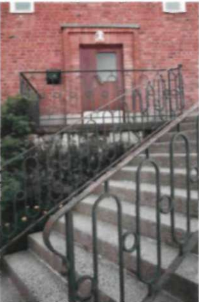
Fasaderna är murade i rött tegel med omfattningar runt trapphusfönstren. Entréerna är markerade med tegelomfattningar.
