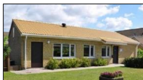
BRF Magnolian Murtegelvägen 43
