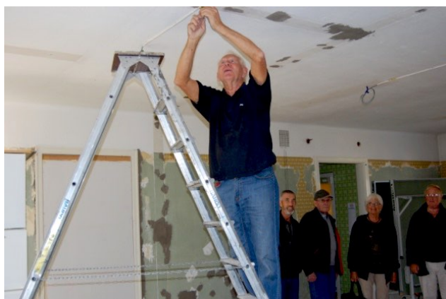
Sven-Erik Lundin installerar elledningar
