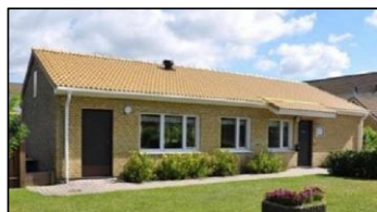
BRF Magnolian Murtegelvägen 43
